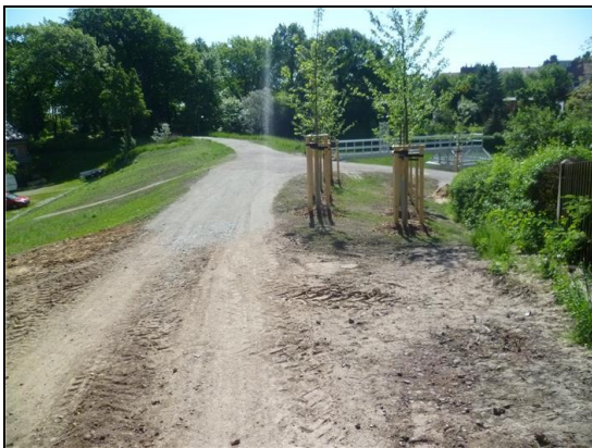
Abb. 7: Ertüchtigtes HWRB Roßthaler Bach, Zuwegung und Dammkrone, 19.05.2017
