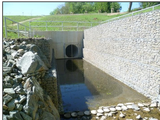
Abb. 8: Auslaufbereich mit Tosbecken, 19.05.2017
