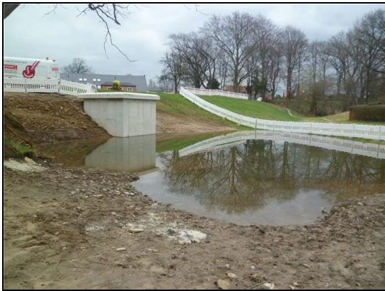
Abb. 5: Während dem Bau: Probestau, 24.03.2017
