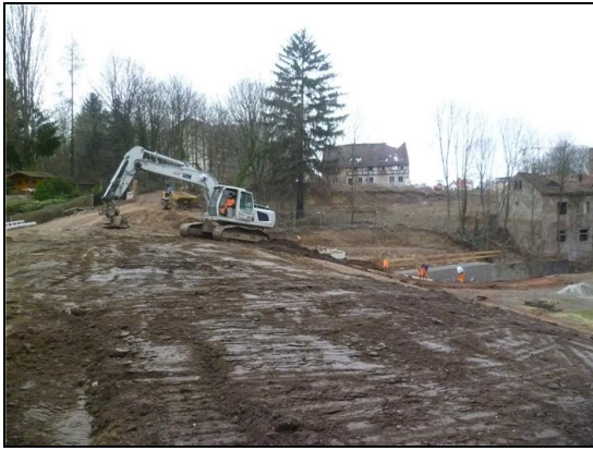
Abb. 3: Während dem Bau: Neuprofilierung der Dammböschung, 24.03.2017
