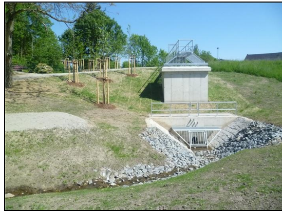
Abb. 6: Ertüchtigtes HWRB Roßthaler Bach, 19.05.2017
