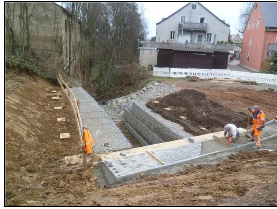
Abb. 4: Während dem Bau: Neugestaltung des Auslaufbereiches, 24.03.2017
